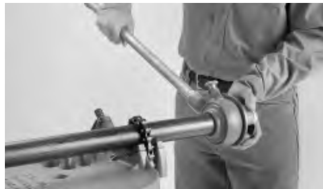
Figure 3 – Montage de la fileteuse sur le tuyau
