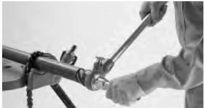
Figure 2 – Alésage de l'extrémité du tuyau
